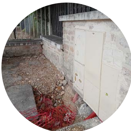
Travaux de séparation du réseau électrique entre le Clos Michel et l'école Barbier à Nuits-Saint-Georges (par entreprises Thomas, MH Services, Enedis et ESME-Solution)
