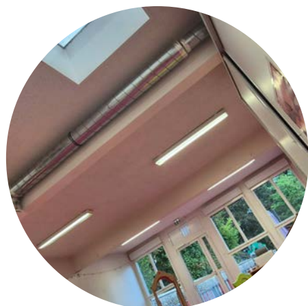
Installation de VMC à la micro-crèche Les Lucioles (par MH Services)
